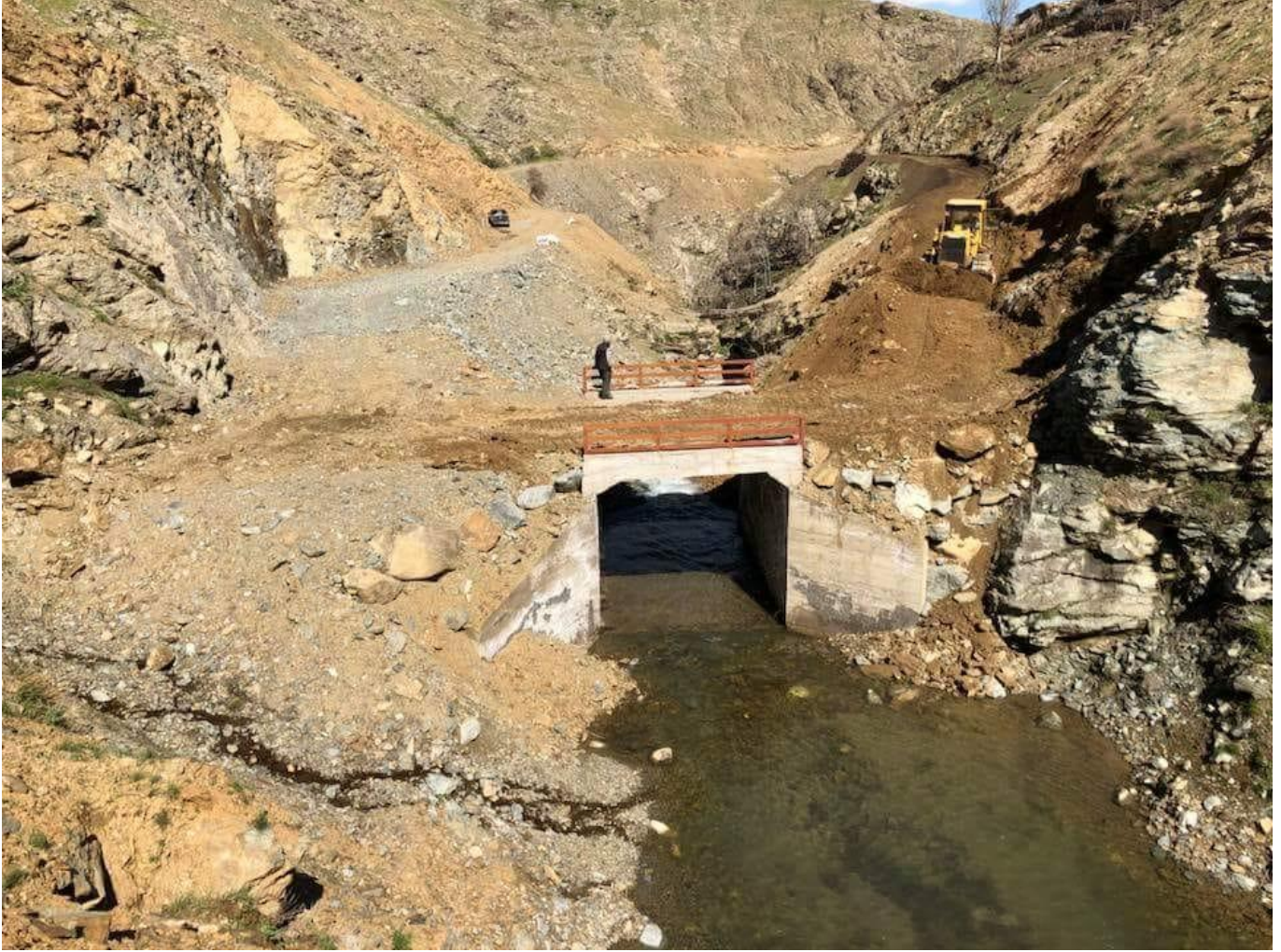
İnardı Köy Yolu Yol Genişletme ve Sanat Yapısı Çalışmaları
