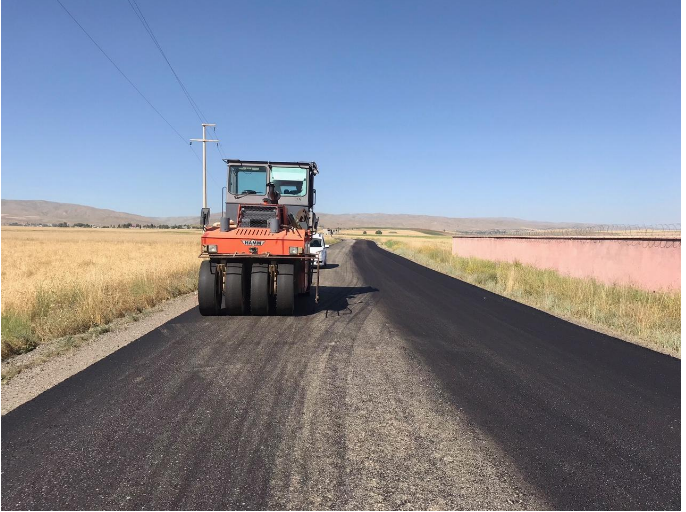
Çukurbağ Durugöze Yedipınar Grup Köy Yolu Bitümlü Sıcak Asfalt Yol Çalışması
