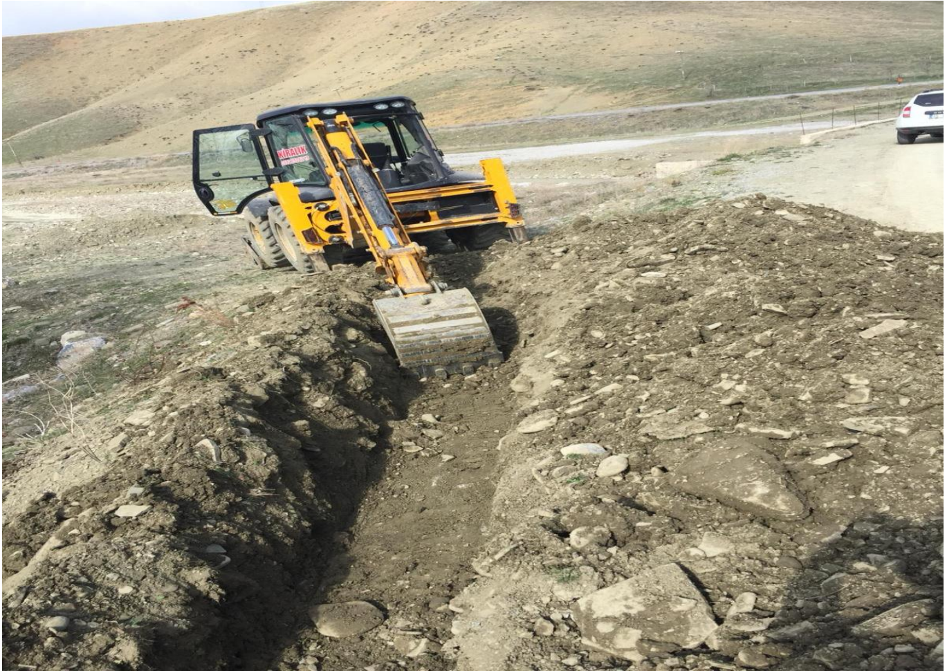
Korkut İlçesi Onevler Mezrası İçme Suyu Yapım İşi
