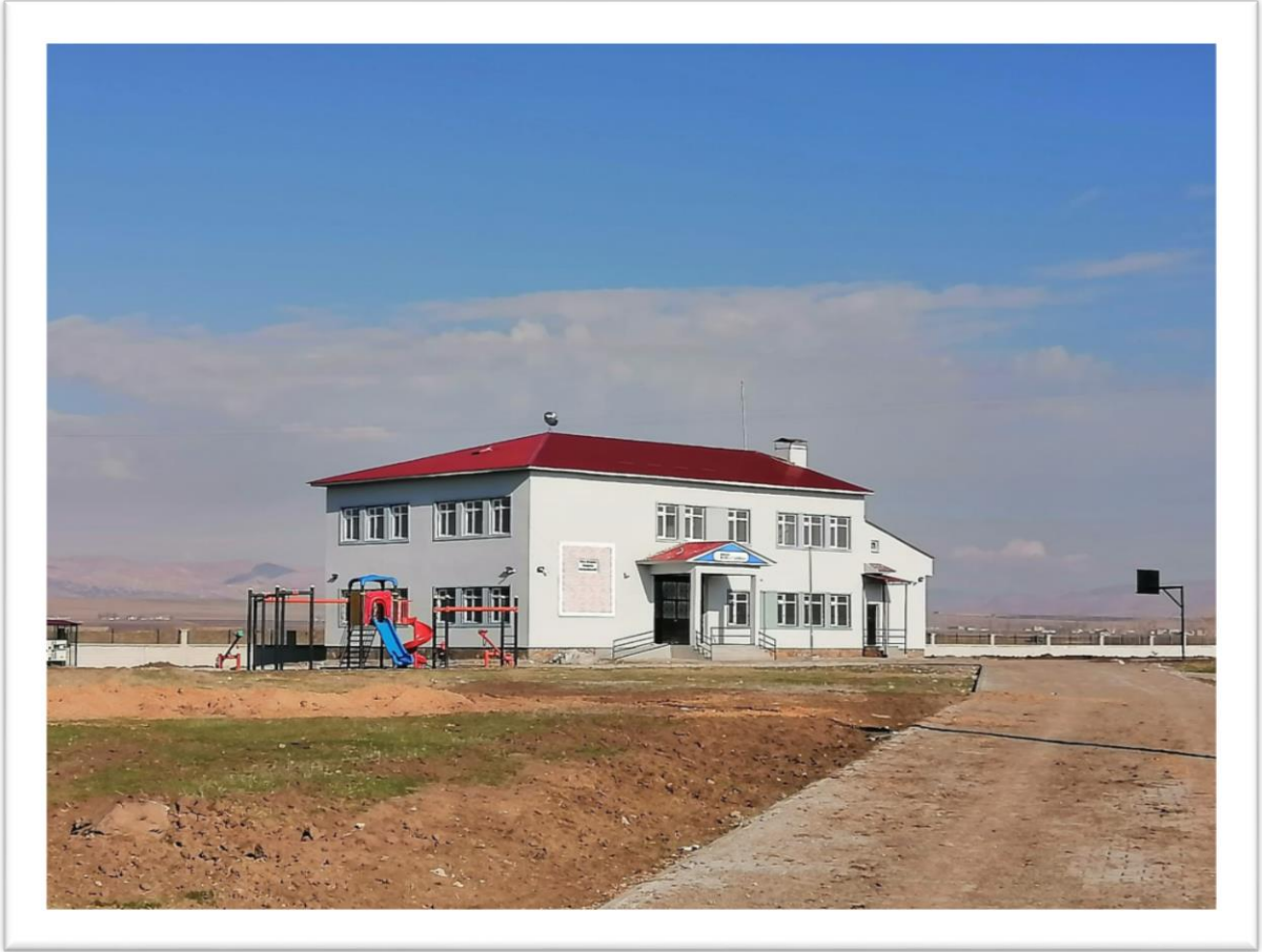
Merkez Bozbulut Köyü 4 Derslikli İlköğretim Okul Binası Proje Tutarı: 6.481.248,66 TL (01.02.2022-23.10.2022)
