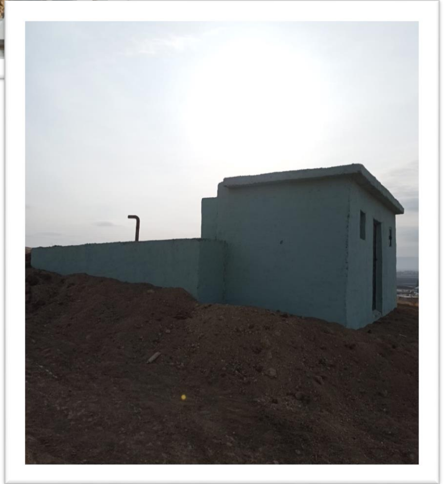
Korkut Yürekli Köyü İçme Suyu Deposu Yapımı
