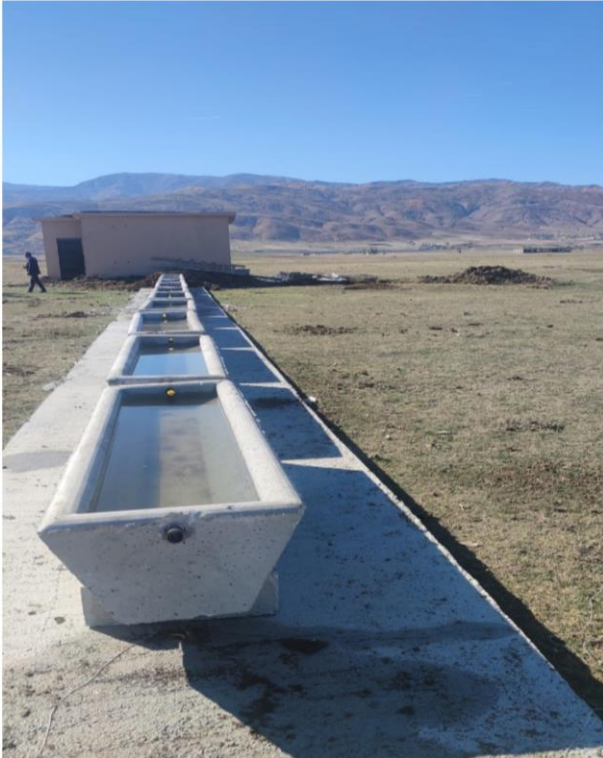
Merkez Kumluca Köyü Güneş Enerjili Hayvan İçme Suyu Tesisi
