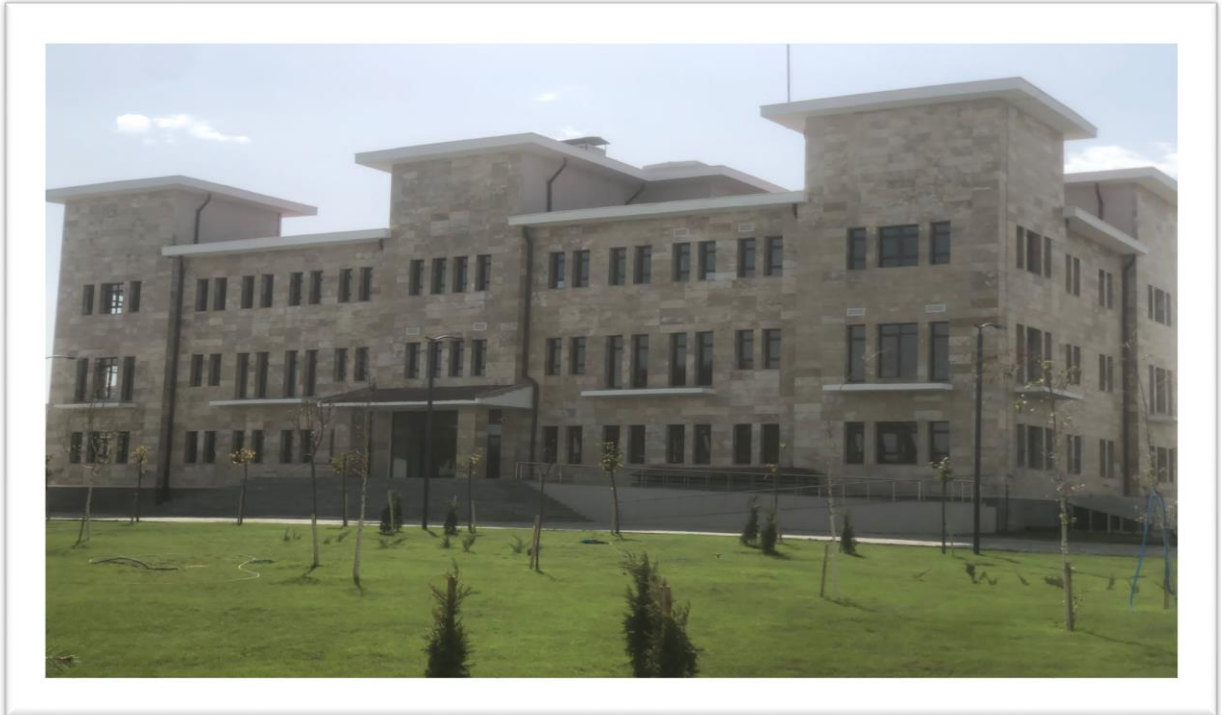
Muş Bulanık Hükümet Konağı Yapımı ve Çevre Düzenlemesi Proje Tutarı: 29.883.935,60 TL (24.08.2020-30.08.2022)
