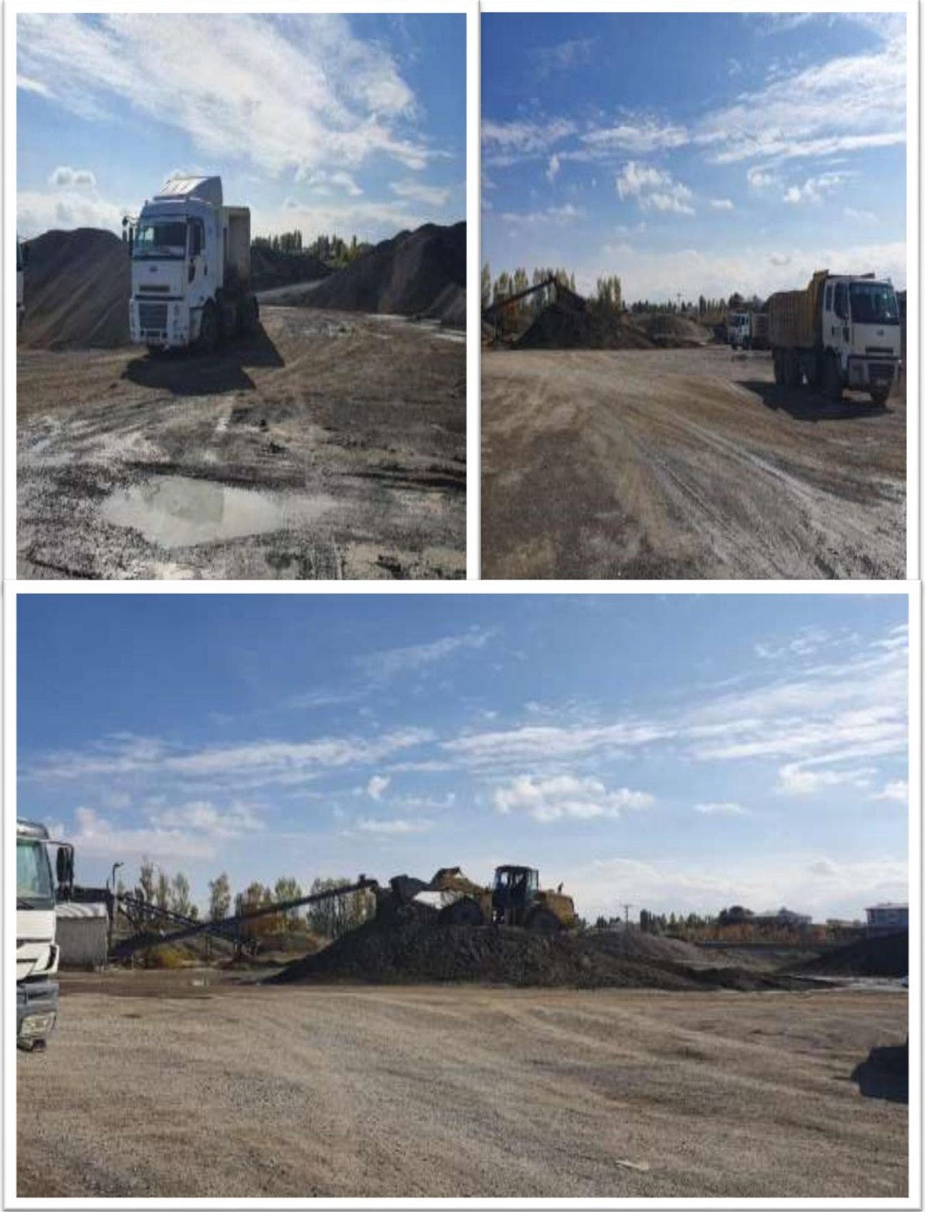
Malazgirt İlçesi Murat Mahallesinde Bulunan Malazgirt Beton Tesislerinin 11.10.2022 Tarihindeki Denetim ve İnceleme Görüntüleri.
