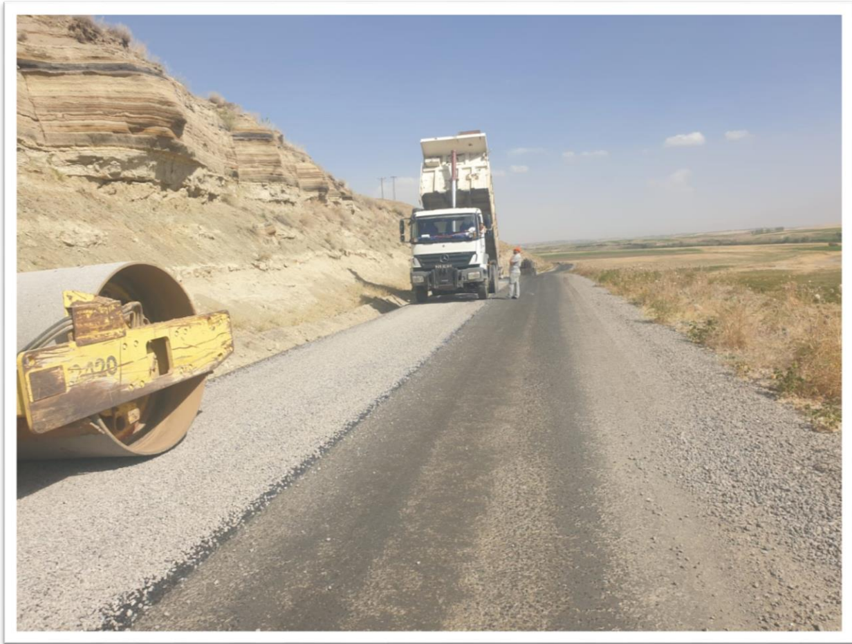
Malazgirt Köy Yolları 2.Kat Asfalt Sathi Kaplama
