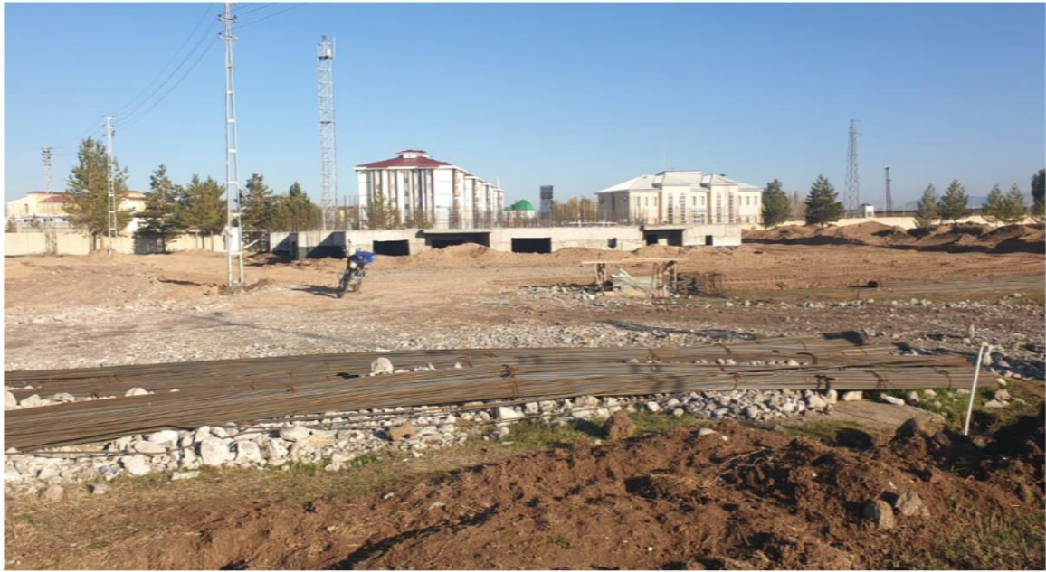
Malazgirt 40 Daireli Jandarma Lojmanları Yapımı ve Çevre Düzenlemesi Proje Tutarı: 35.870.040,16 TL (31.08.2022-23.12.2023)
