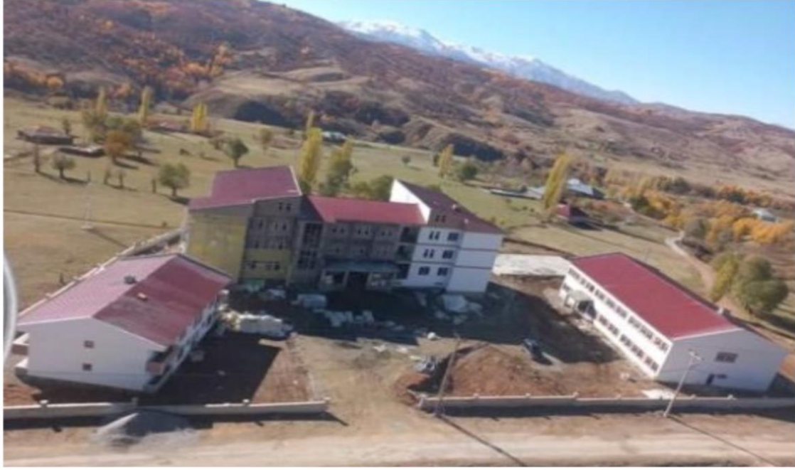
Merkez Üçevler Köyü 100 Kişilik Pansiyon + 8 Derslikli Okul Binası + 4 Daireli Lojman Proje Tutarı: 33.662.623,60 TL (01.10.2021-30.05.2023)
