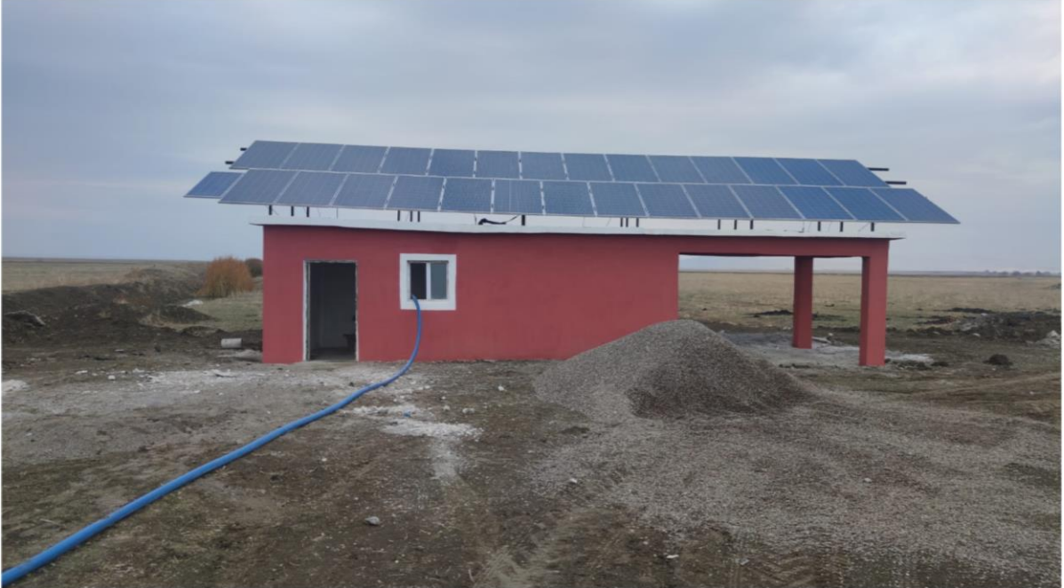
Merkez Suboyu Köyü GES İçme Suyu Tesisi
