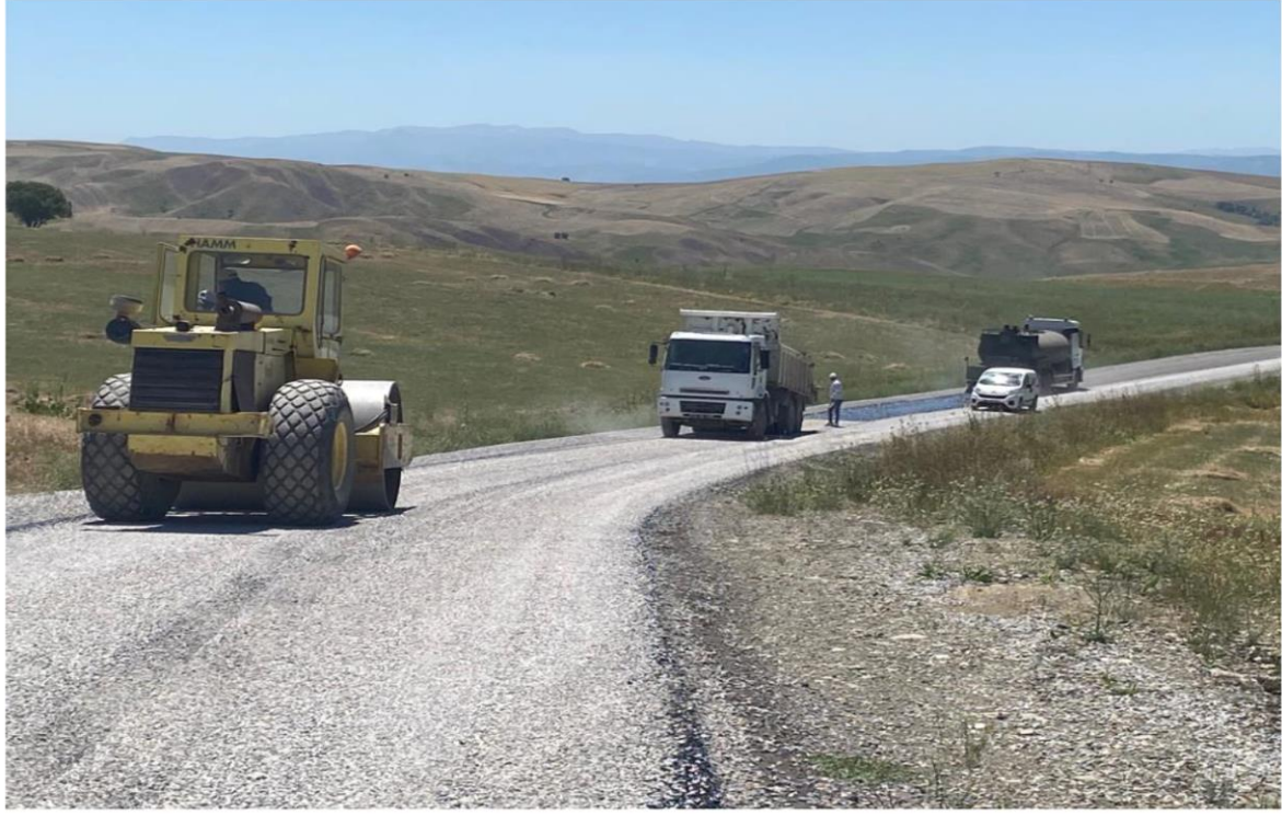
Korkut Balkır-Güven Grup Köy Yolu 2.Kat Asfalt Sathi Kaplama Çalışması
