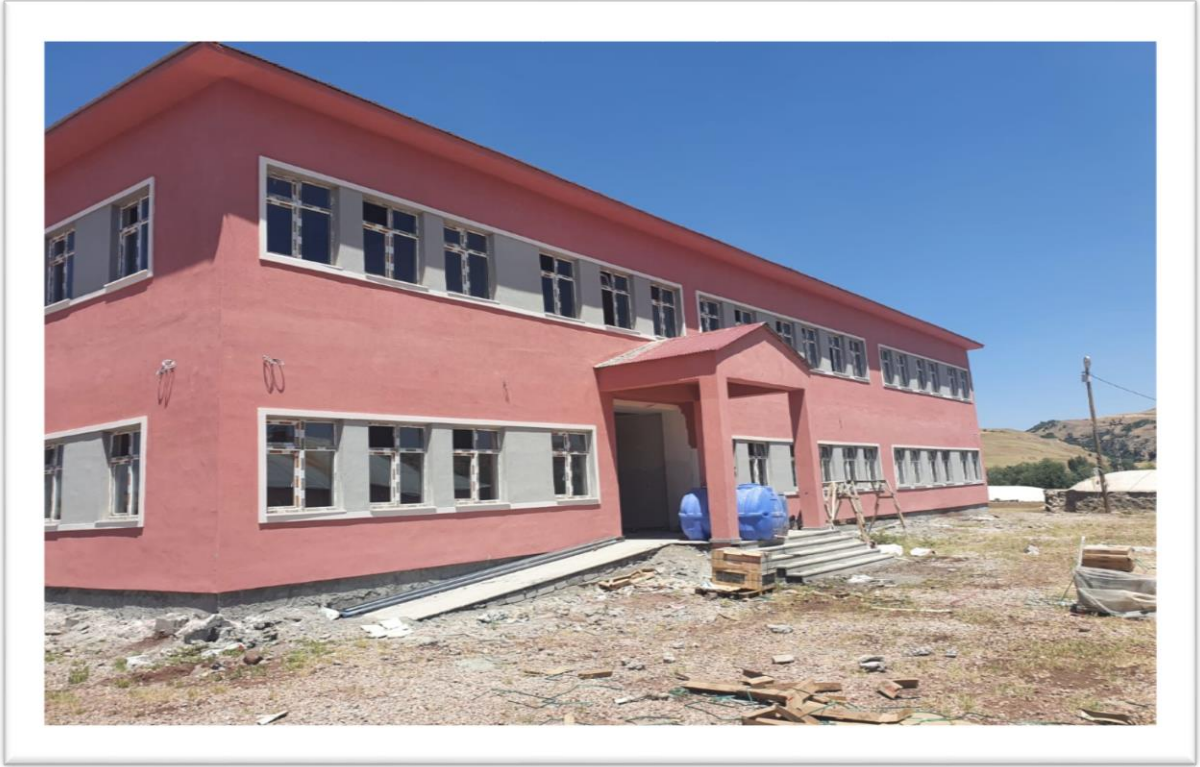
Korkut Yolgözler Köyü 8 Derslikli Okul Binası Yapımı Proje Tutarı: 5.294.157,37 TL (06.08.2021-11.07.2022)
