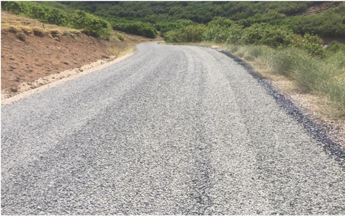
Varto İlçesi Zorabat, Taşlıyayla ve Küçüktepe -Çağlek-Yeşildal grup köy yolları 2.kat asfalt çalışmaları
