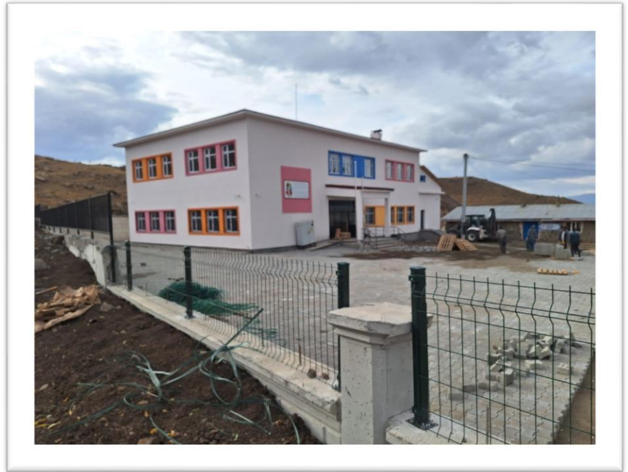
Varto Buzlugöze 4 Derslikli Okul Yapımı ve Çevre Düzenlemesi Proje Tutarı: 9.060.210,93 TL (25.11.2022-24.11.2023)
