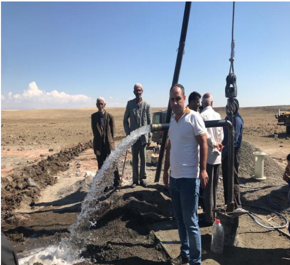
Gülkoru Köyü İçme Suyu Sondaj/MALAZGİRT
