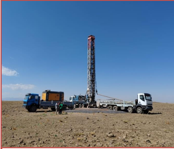
Gülkoru Köyü İçme Suyu Sondaj Yapım İşİ/BULANIK
