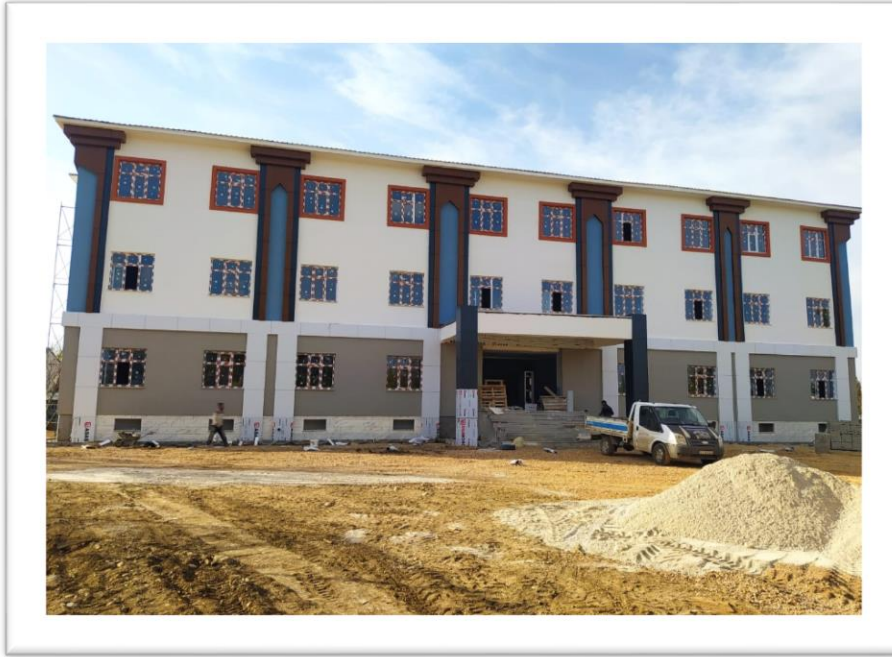
Muş Şehit İzzetin Polat 16 Derslikli İlkokul Binası Yapımı Proje Tutarı: 30.013.366,73 TL (09.11.2022-14.12.2023)
