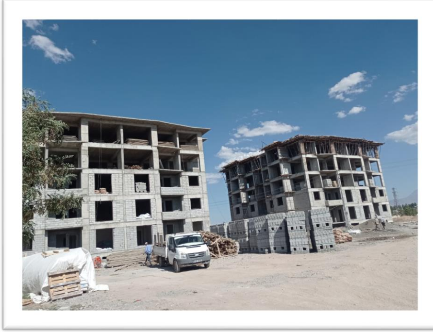
Malazgirt 40 Daireli Jandarma Lojmanları Yapımı Proje Tutarı: 33.383.130,88TL (31.08.2022-29.07.2024)
