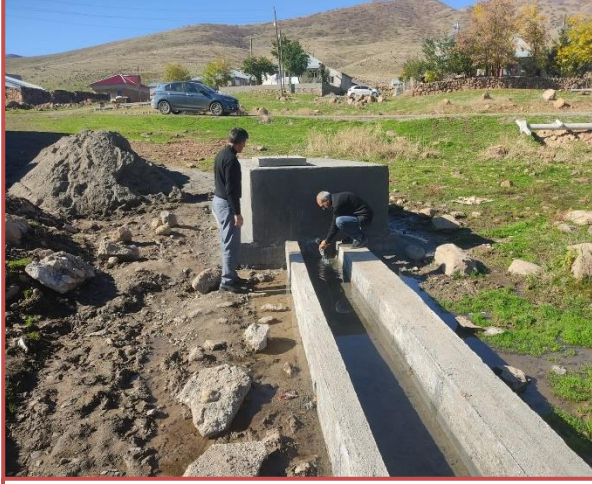
Karabey Köyü Biriktirme Havuzlu Çeşme
