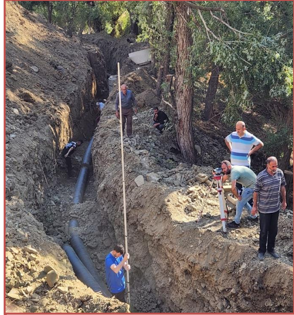
Tan Köyü Kanalizasyon Yapımı/KORKUT
