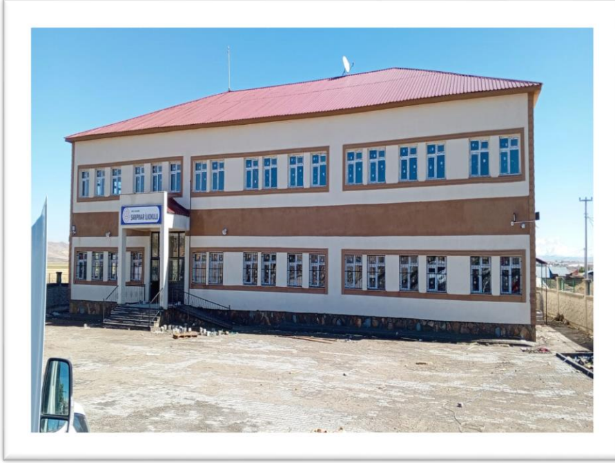
Bulanık Sarıpınar Beldesi 8 Derslikli İlkokul Binası Yapımı Proje Tutarı: 11.103.630,36 TL (08.09.2022-13.10.2023)
