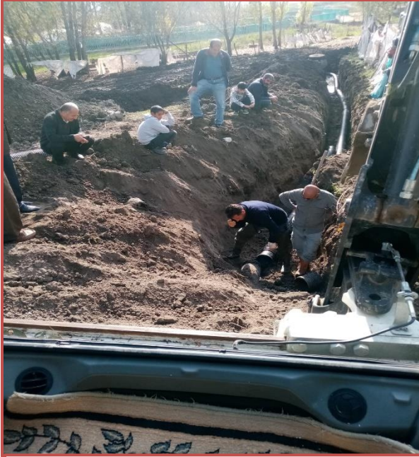
Kanalizasyon Bakım ve Onarım Çalışmalarımız
