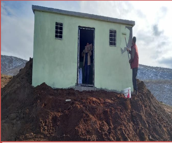
Yolgözler Köyü İçme Suyu Deposu/KORKUT
