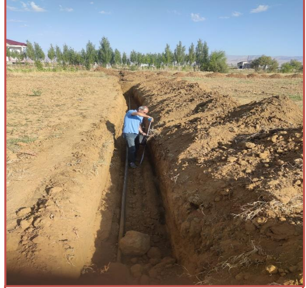
Karakuyu Köyü Ek Şebeke Hattı Yapımı
