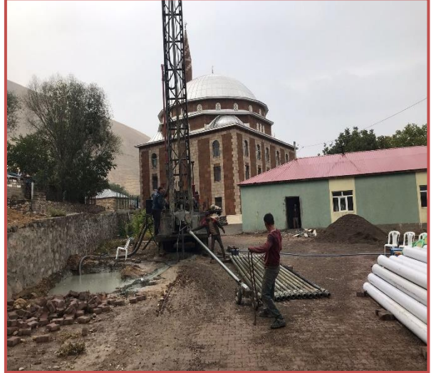
Akpınar Ky İme Suyu Sondaj Yapımı
