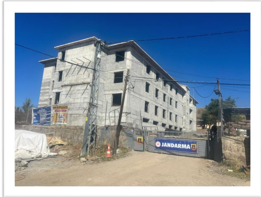
Varto Merkez Jandarma 24 Vardiyalı Yatakhane Yapım İşİ Proje Tutarı: 27.824.900,05 TL (03.03.2023-03.09.2024)
