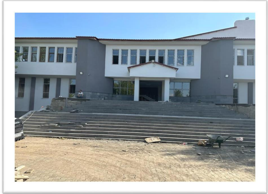
Muş Merkez ve Malazgirt İlçesi 2 Adet Kültür Merkezi Güçlendirme ve Onarımı Proje Tutarı: 16.319.540,76 TL (04.04.2023-10.09.2023)
