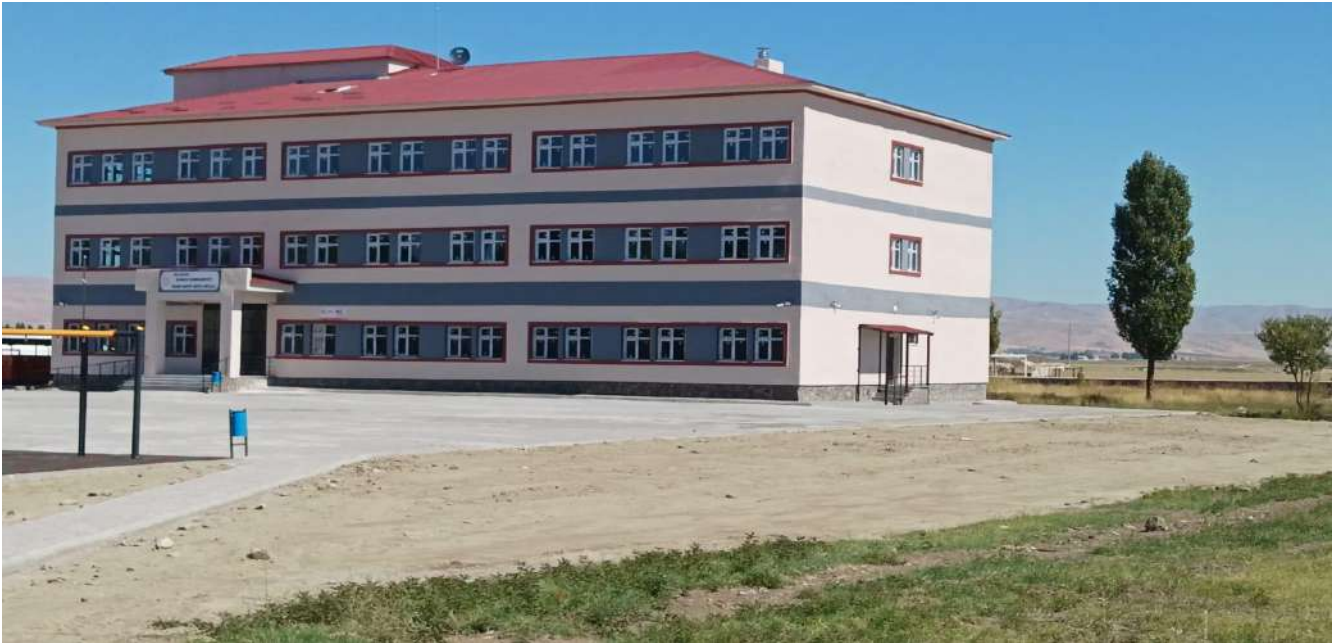
Muş Sungu Cumhuriyet 12 Derslikli İHO Binası Yapımı ve Çevre Düzenlemesi İşi
