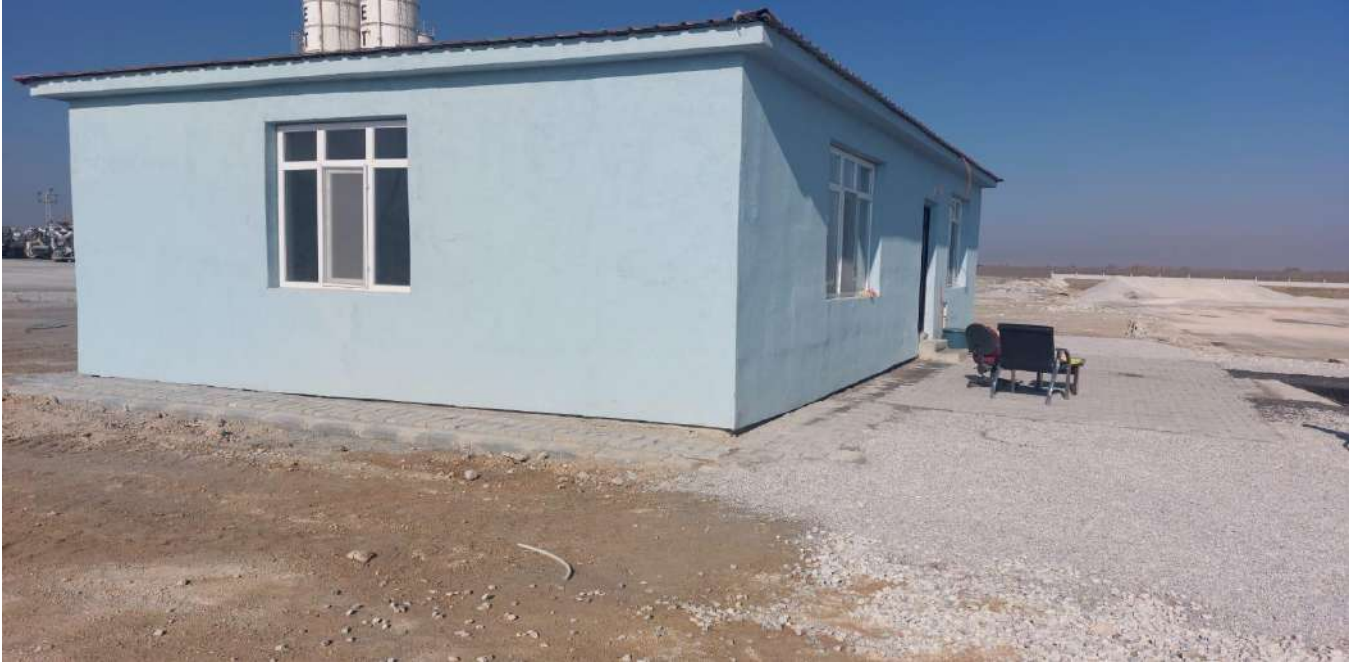
Muş İl Özel İdaresi Asfalt Plentine Ait Bekçi Kulübesi ve Çevre Düzenlemesi Yapımı İşi Proje Tutarı 6.178.675,90 TL Başlama Bitiş Tarihi 20.07.2024-15.11.2024
