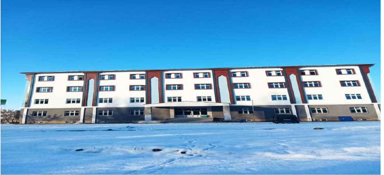
Bulanık 24 Derslikli Turgut Özal İlköğretim Binası Yapımı ve Çevre Düzenlemesi İşi Proje Tutarı 48.315.750,56 TL Başlama Bitiş Tarihi 21.11.2022---07.01.2025
