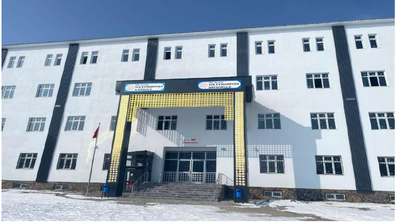
Muş İli Bulanık İlçesi Süleymanpaşa 24 Derslikli İlkokulu Binası ve Çevre Düzenlemesi Yapımı İşi Proje Tutarı TL Başlama Bitiş Tarihi 21.11.2022- 25.06.2025
