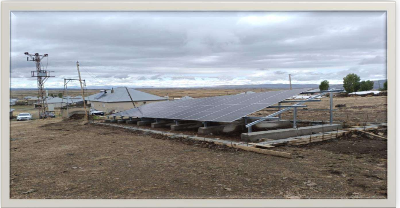
Malazgirt İlçesi Örenşar Köyü Güneş Enerjili İçme Suyu Yapım İşi
