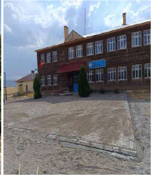
Oğlakkaya Köyü Parke Yapımı
