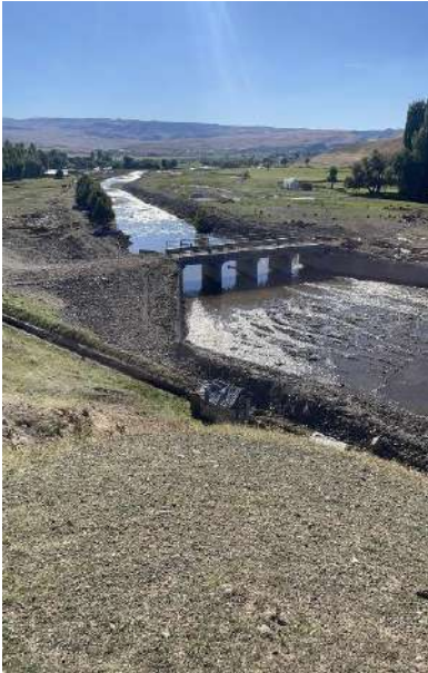
Varto Cıvcatı Kövü Köprüsü
