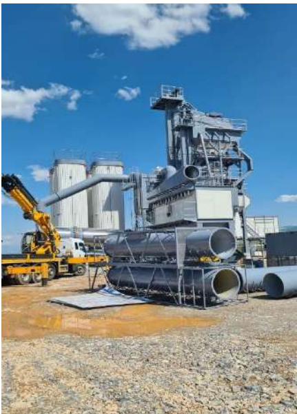
Asfalt Plenti Şantiyesi
