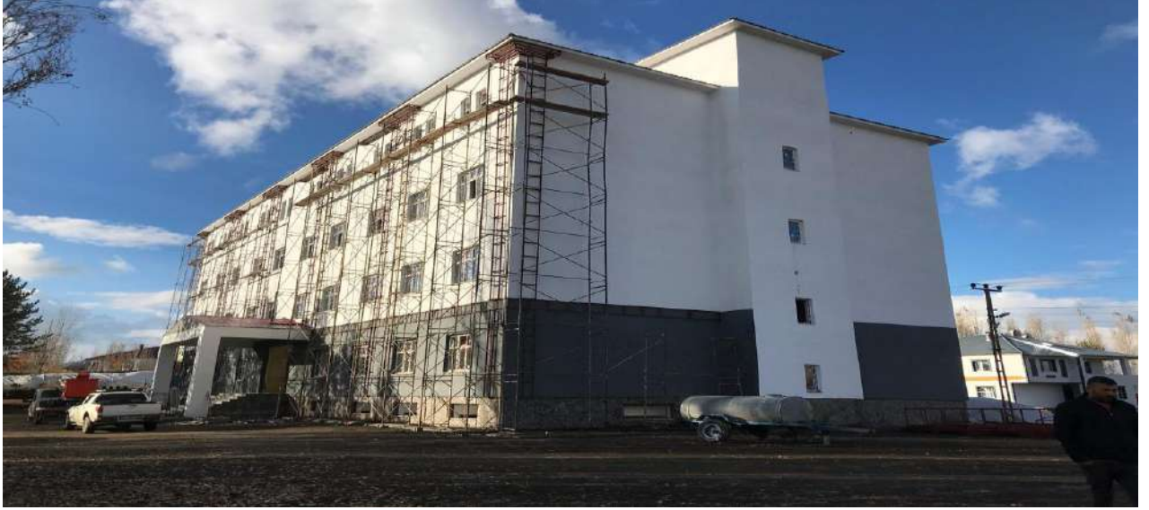
Bulanık 24 Derslikli İHO Okul Binası Yapımı ve Çevre Düzenlemesi İşi Proje Tutarı 43.274.380,66TL Başlama Bitiş Tarihi 21.11.2022-28.01.2025
