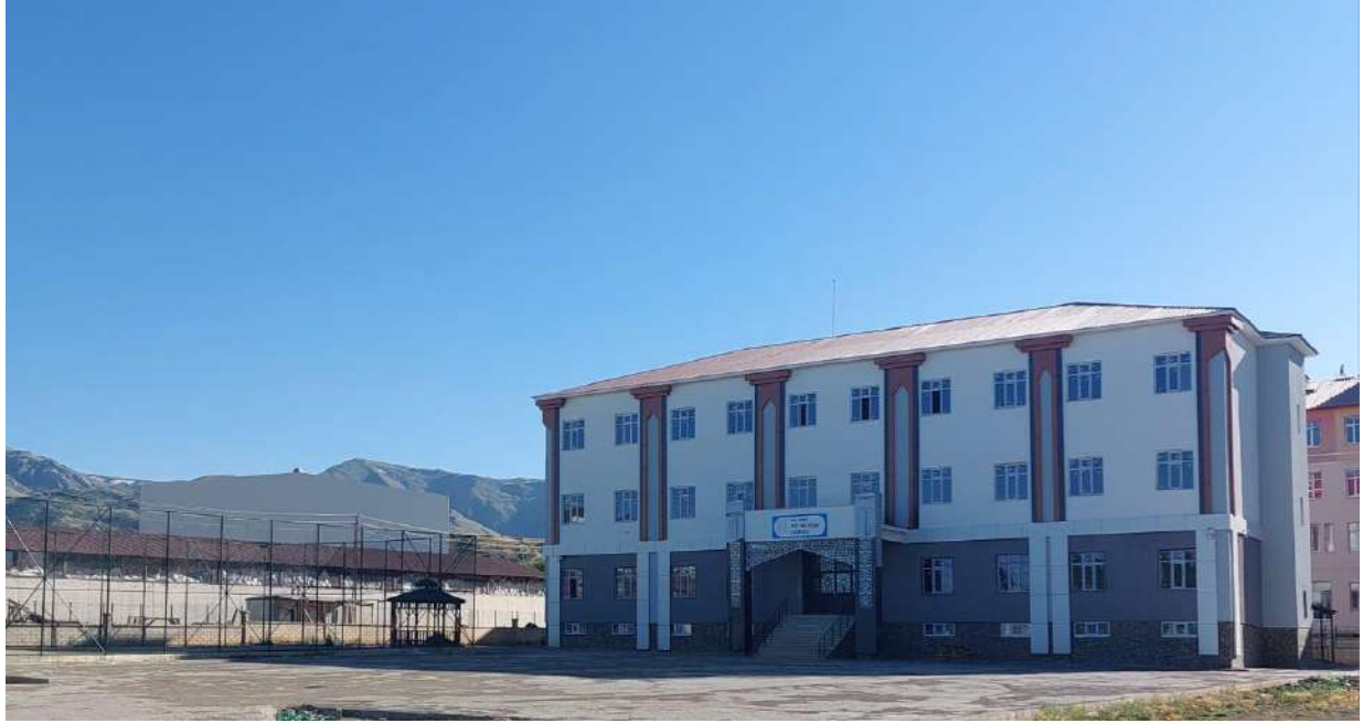
Muş Merkez 2071 Melikşah 16 Derslikli Ortaokul Binası Yapımı ve Çevre Düzenlemesi İş Proje Tutarı 26.968.108,15 TL Başlama Bitiş Tarihi (11.01.2023 -20.04.2024)
