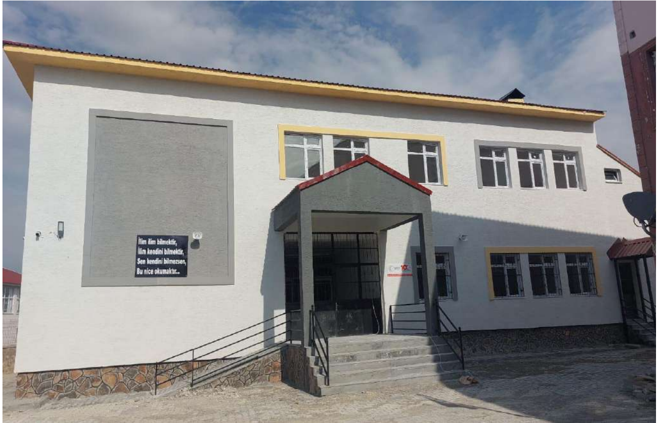
Muş Bulanık Erentepe Beldesi Gazi Mahallesi 4 Derslikli Anaokulu Yapımı ve Çevre Düzenleme İşİ Proje Tutarı 7.860.812,24 TL Başlama Bitiş Tarihi 29.11.2022-14.08.2024
