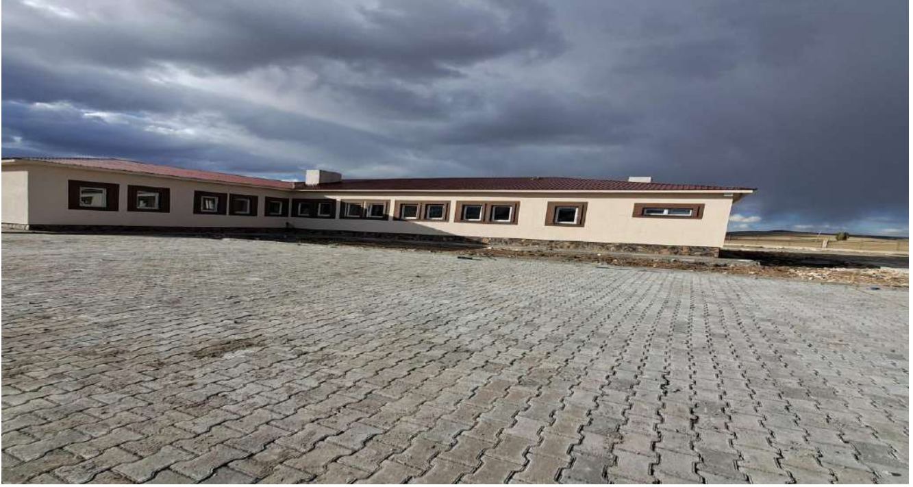
Muş Malazgirt Adaksu Jandarma Karakol Komutanlığı Hizmet Binası Yapımı ve Çevre Düzenlemesi Yapım İşi
