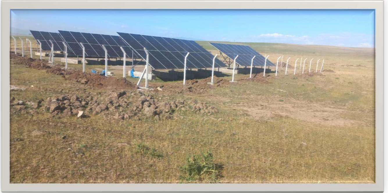
Malazgirt İlçesi Güllü Köyü Güneş Enerjili İçme Suyu Yapım İşi
